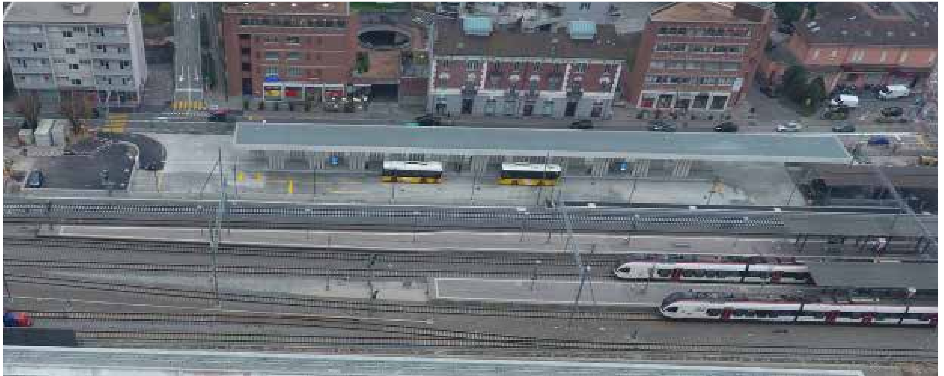
Mendrisio, quartier de la gare, pôle intermodal
