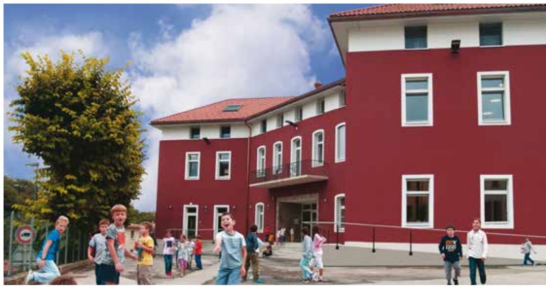
Centre scolaire de Arzo
