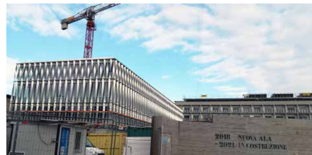
Projet et chantier OBV Mendrisio
